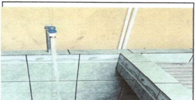
Foto 3: Sustitución de la tubería de agua potable
