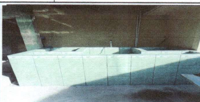
Foto 2: Cambio e instalación de pila
